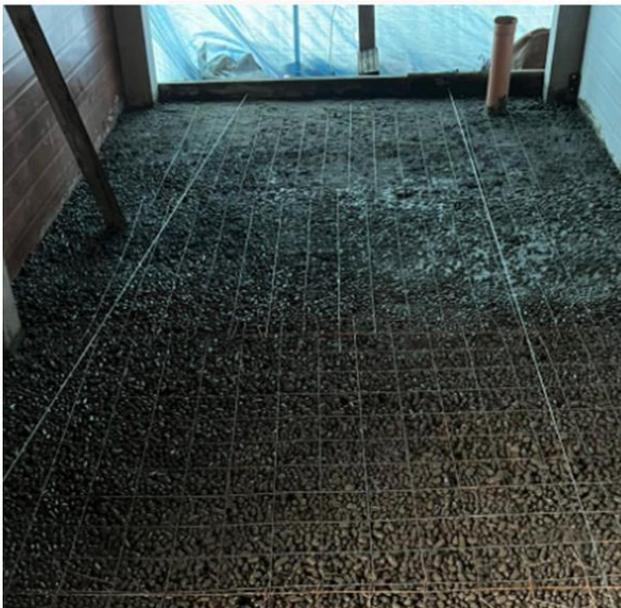
Выполнена цементно-песчаная стяжка с устройством теплоизоляции и разуклонкой для установки сливных трапов на площади 446,22 м<sup>2</sup>
