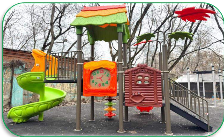
Улица Сельскохозяйственная, д.8 ремонт противоударного покрытия на детской площадке, установка малых архитектурных форм
