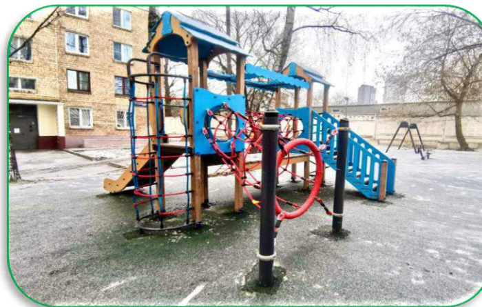
Улица Сельскохозяйственная, д.2 ремонт противоударного покрытия на детской площадке, установка малых архитектурных форм
