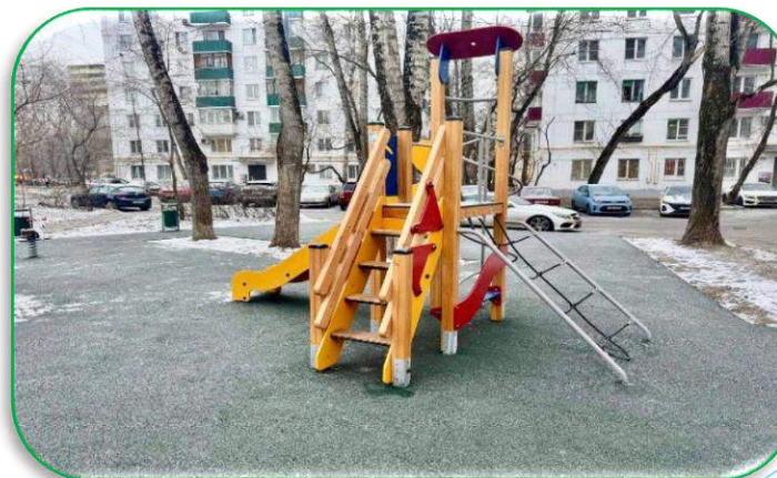
Улица Бажова, д.16 ремонт противоударного покрытия на детской площадке, установка малых архитектурных форм
